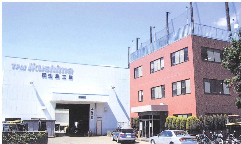
本社・第一工場
