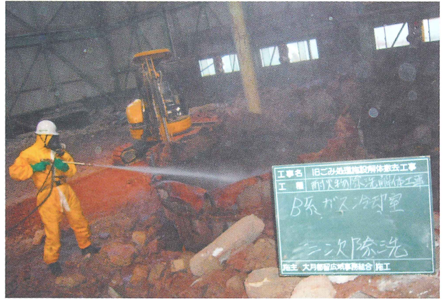
大月環境センター耐火物高圧DXN除洗
