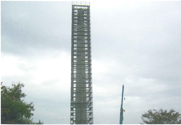
山形最上環境保全センター煙突除洗システム設置
