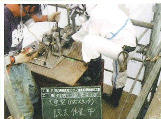
超高圧除去装置設置
