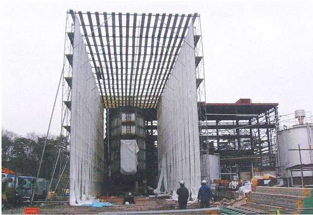
東証一部N社暴露防止養生施工
