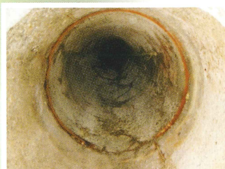
超高圧除去工法施工後
