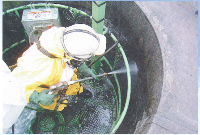
山形最上環境保全センター煙突DXN除洗
